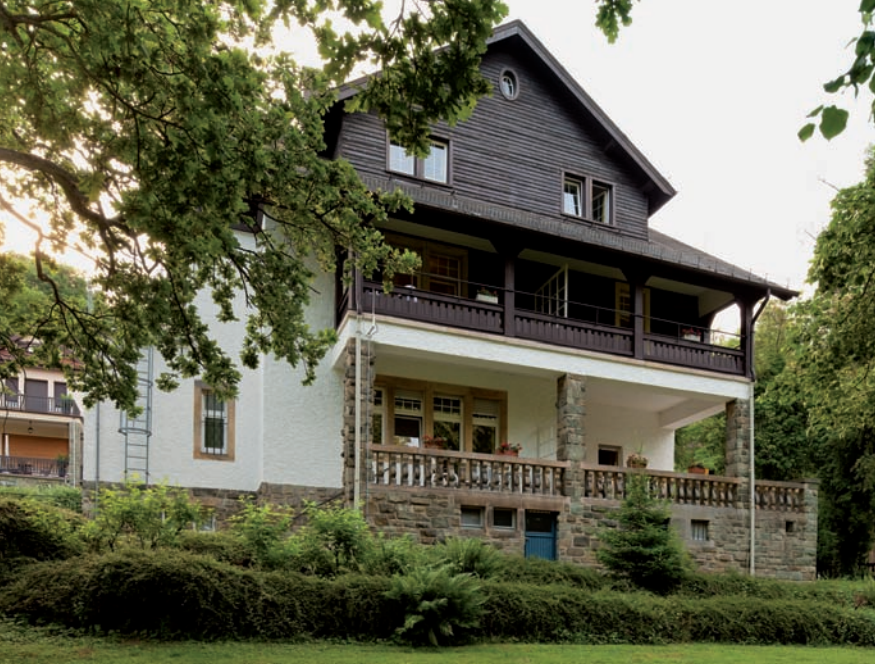
Die Stationen sind auf drei gut erreichbare Gebäude im Klinikgelände verteilt.
